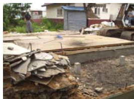
躯体上部を撤去
