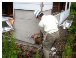
ハンマーで外壁を壊す
