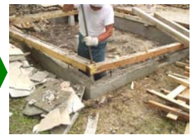
土台の分離・撤去
